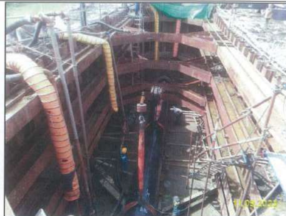
ข) การวางท่อโดยวิธีดันทอด (Boring)
