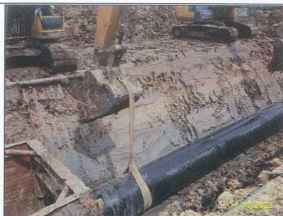
ก) การวางท่อโดยวิธีขุดเปิด (Open Cut)
