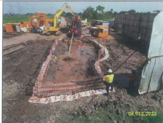
ก) การวางท่อโดยวิธีเจาะลอด (Horizontal Directional Drill : HDD)
