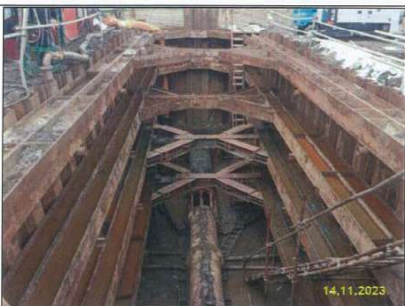
ค) การวางท่อโดยวิธีดันลอด (Boring)
