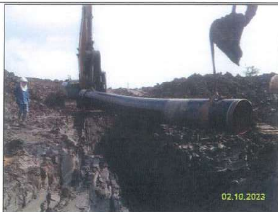
ก) การวางท่อโดยวิธีขุดเปิด (Open Cut)
