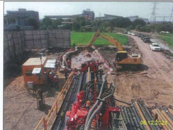
ก) การวางท่อโดยวิธีเจาะลอด (Horizontal Directional Drill : HDD)
