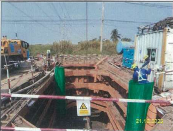
ค) การวางท่อโดยวิธีดินสอด (Boring)
