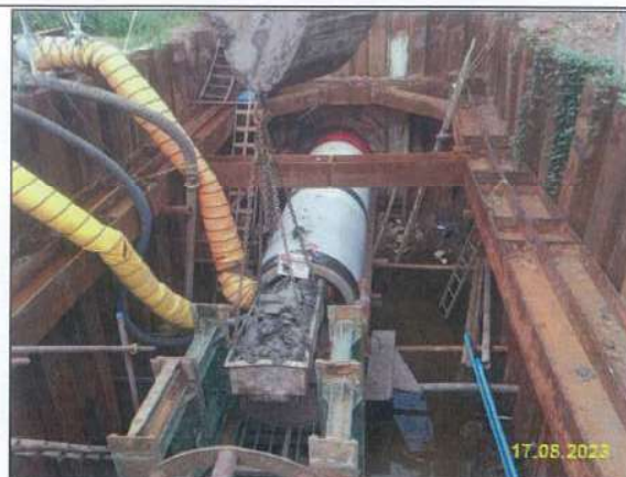
ข) การวางท่อโดยวิธีดันทอด (Boring)
