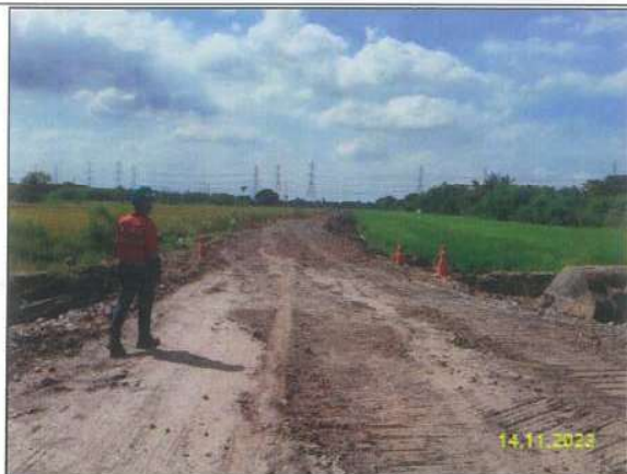
ก) การปรับพื้นที่ก่อสร้าง (Clearing & Grading)
