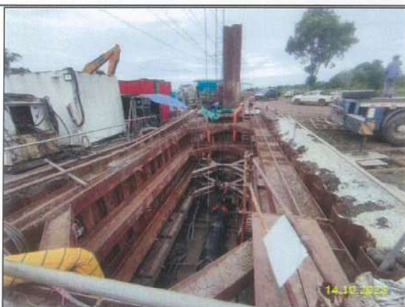
ข) การวางท่อโดยวิธีดินสอด (Boring)
